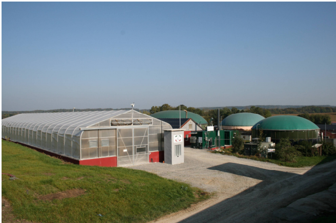
Biogasanlage mit Gärrestetrocknungsanlage: Kapazität: 450 kW
